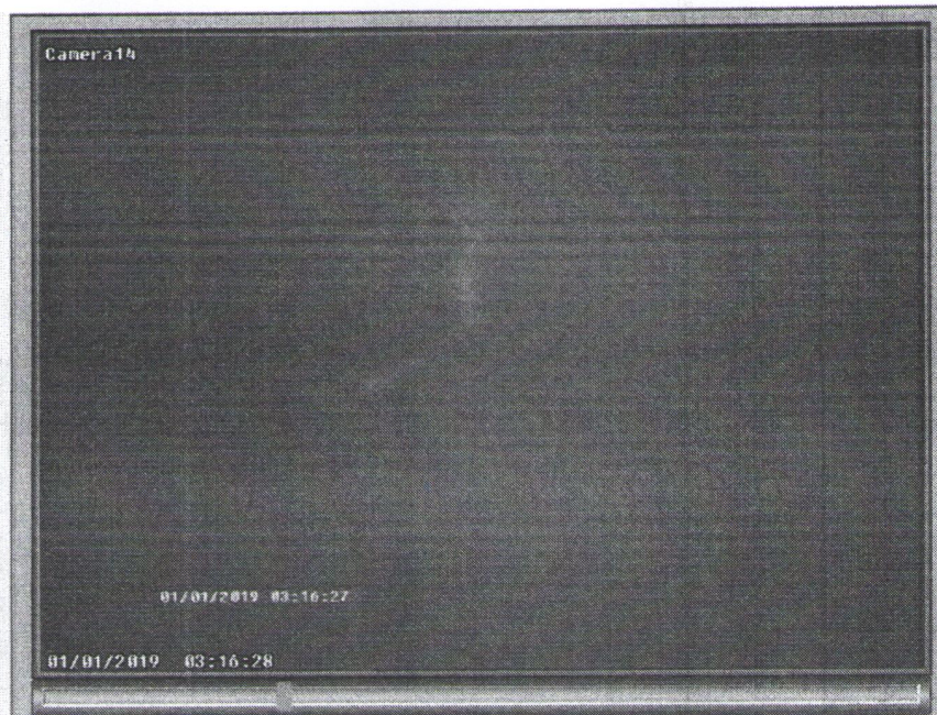
Иллюстрация 11. Скриншот экрана монитора компьютера при просмотре видеозаписи с камеры № 14 на 3-ем этаже ГСК «Автодом», на период времени 03:16:28. Вид заполнения дымом коридора 3-го этажа гаражного комплекса ГСК «Автодом».
